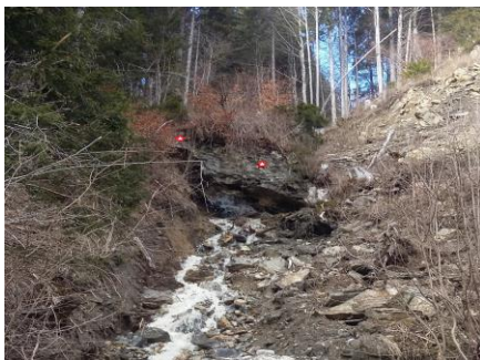
Instabiler Felsblock mit Lage- und Erschütterungssensoren oberhalb Strasse
